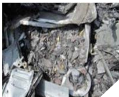
Residuos de concreto
