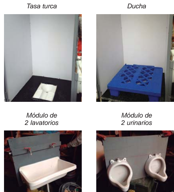
Figura 2c. El interior del módulo.
