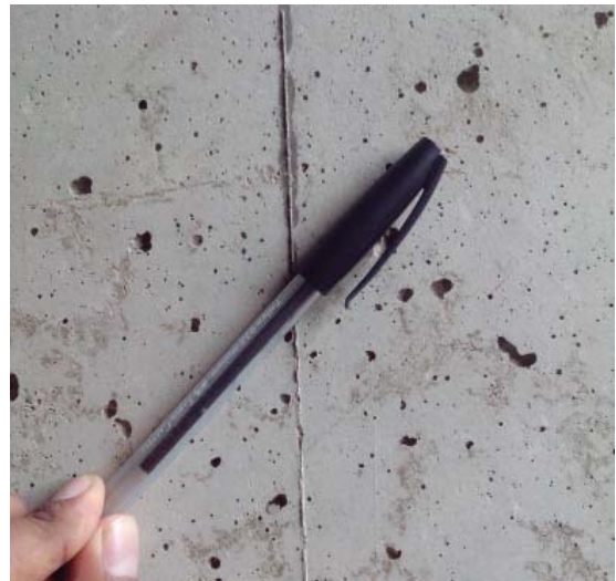
Figura 6. Exceso de burbujas superficiales en muros.
