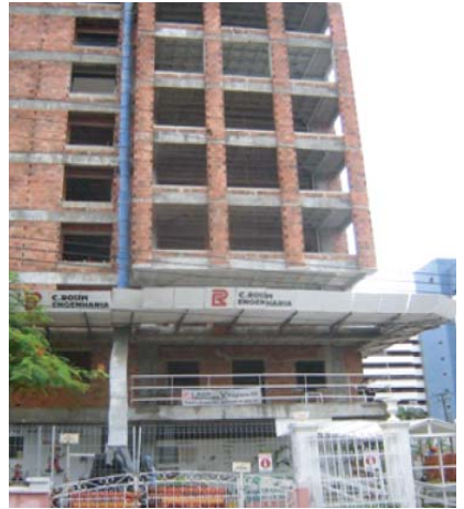
Tube para verter desechos en los contenedores
