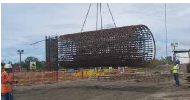
Figura 6. Montaje de Pilotes Prearmados. (Costa Verde – Lima).
