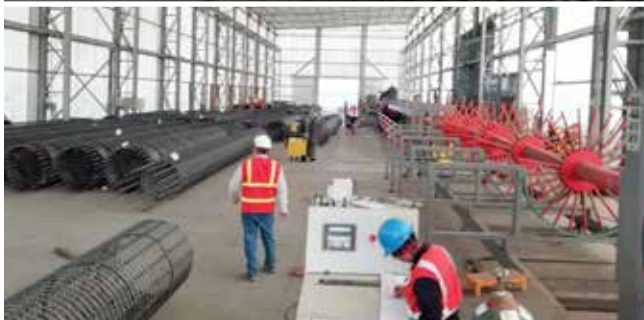
Figura 5. Stock de Pilotes en Planta / Pilote Prearmado (Pisco) / Transporte de canastillas
