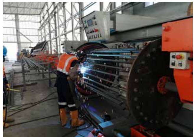
Figura 4. Prearmado de Pilotes mediante maquinas Piloterías (Pisco).
