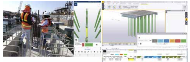
Figura 7. Seguimiento de la instalación de Pilotes en Obra mediante app Trimble Connect. (Puerto San Martín - Paracas).
