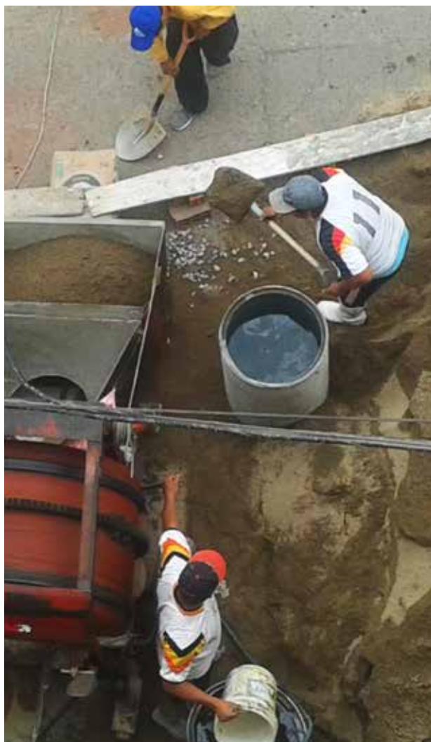
PREPARACIÓN DEL CONCRETO
