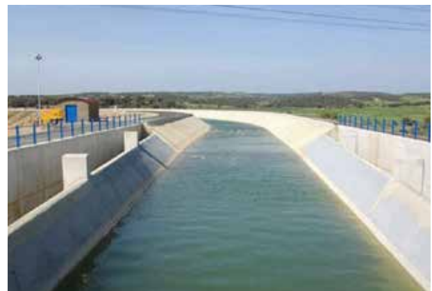
CANAL DE CONCRETO
