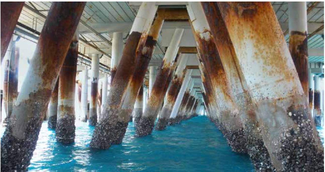
PILOTES DE CONCRETO ARMADO EN AGUA DE MAR
