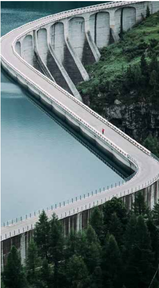
PRESA DE CONCRETO
