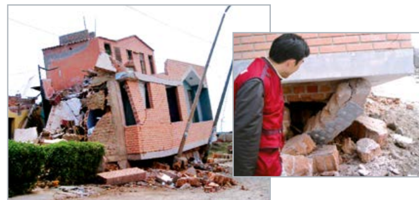
Figura 2 Vivienda dañada debido al terremoto de Pisco. 15 Agosto, 2007.
