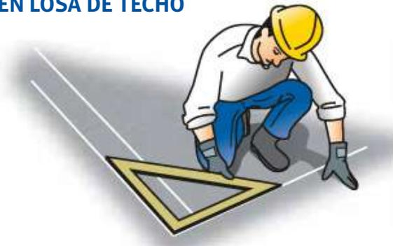
Cuando el muro se construye a partir de una losa de techo, también se deben marcar los ejes donde se van a construir los muros ayudados de un tiralíneas.
